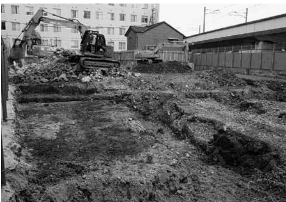
Abbildung 3 Vollansicht vor der Vermessung (von Nordwesten)
